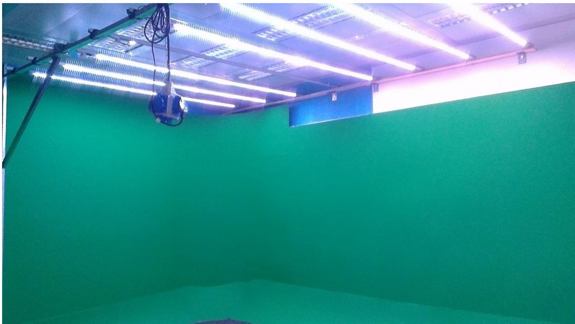
**Abbildung 3.8: Stationäre Beleuchtungsanlage mit RGB-LED-Streifen**
