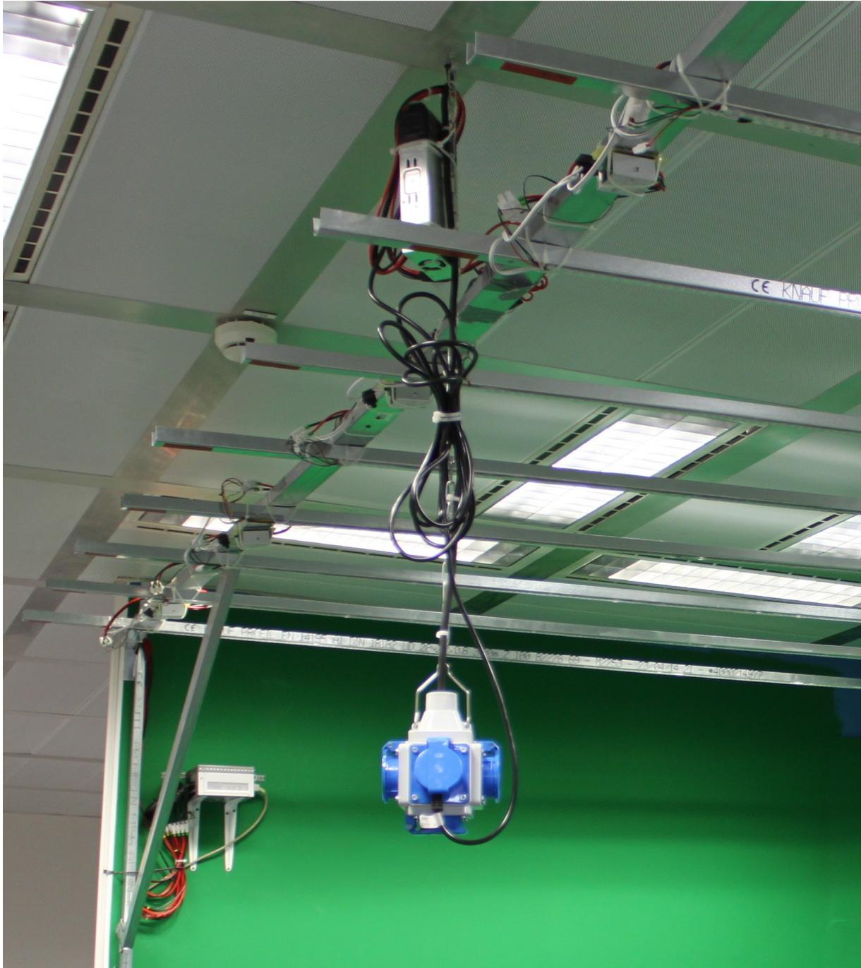
**Abbildung 7.2: Beleuchtungsanlage B3 mit neuem Netzgerät (Hintergrund) und am Querträger befestigte LED-Profile und PWM-Dimmer.**
