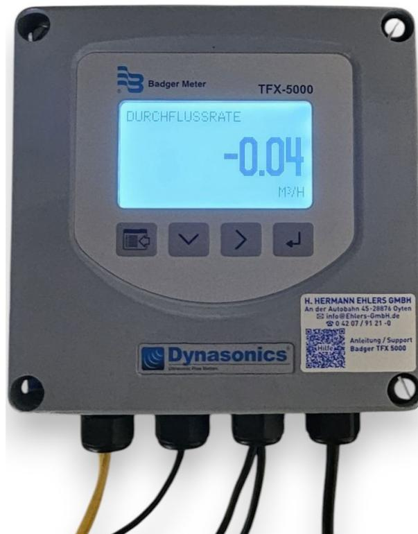
Abbildung 1: Der TFX-5000 Energy Messwertumformer.
