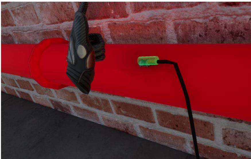
Abbildung 20: Die Montage des RTD 2 am heißen Vorlauf.
